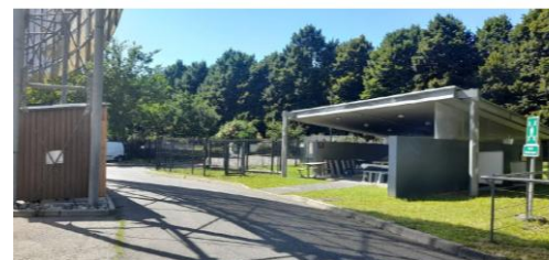
Zone existante ciblée pour implantation du nouveau bâtiment
